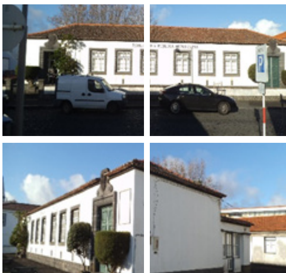
Imagens do edifício da antiga escola primária da Madalena (Foto: D.R.)
